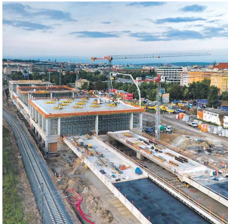
NOVÁ STANICE Praha-Bubny umožní přímý přestup na metro linky C a pohodlný přestup na tramvaje. Foto: Správa železnic
