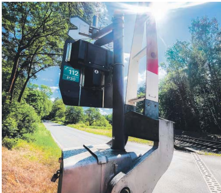
DO KONCE roku Správa železnic plánuje obnovu polepu na všech železničních přejezdech, vyrobit by se mělo na 22 tisíc reflexních štítků. Foto: SŽ
